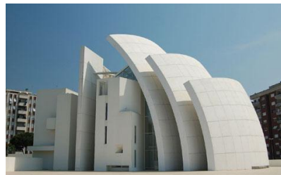
Fassaden Verkleidung mit Quantz
