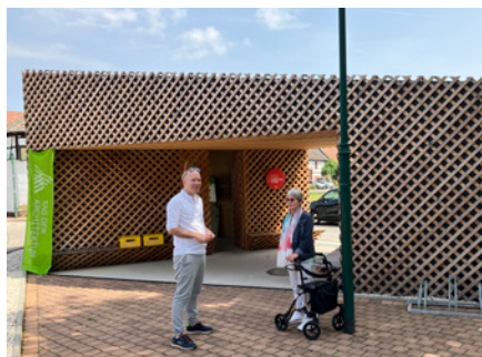
Bild: Pasel-K Architects
