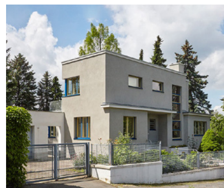
Das Wohnhaus Sparmberg in Gera von Thilo Schoder erhielt 2016 den ersten Preis beim Bundespreis für Handwerk in der Denkmalpflege Thüringen (Architektin der Sanierung: Dr.-Ing. Anja Löffler, Gera)
