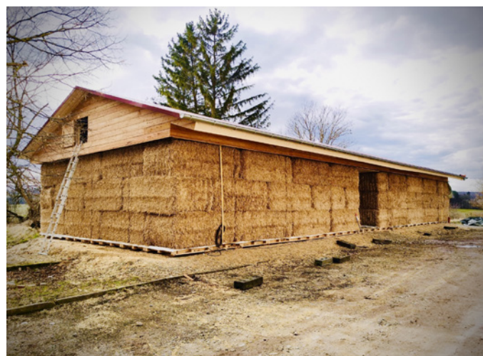
Im Entstehen: Strohballenbau in Holzdorf (Entwurf: Z-Architektur, Weimar)
