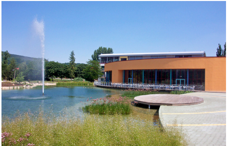
Landessportschule Bad Blankenburg
