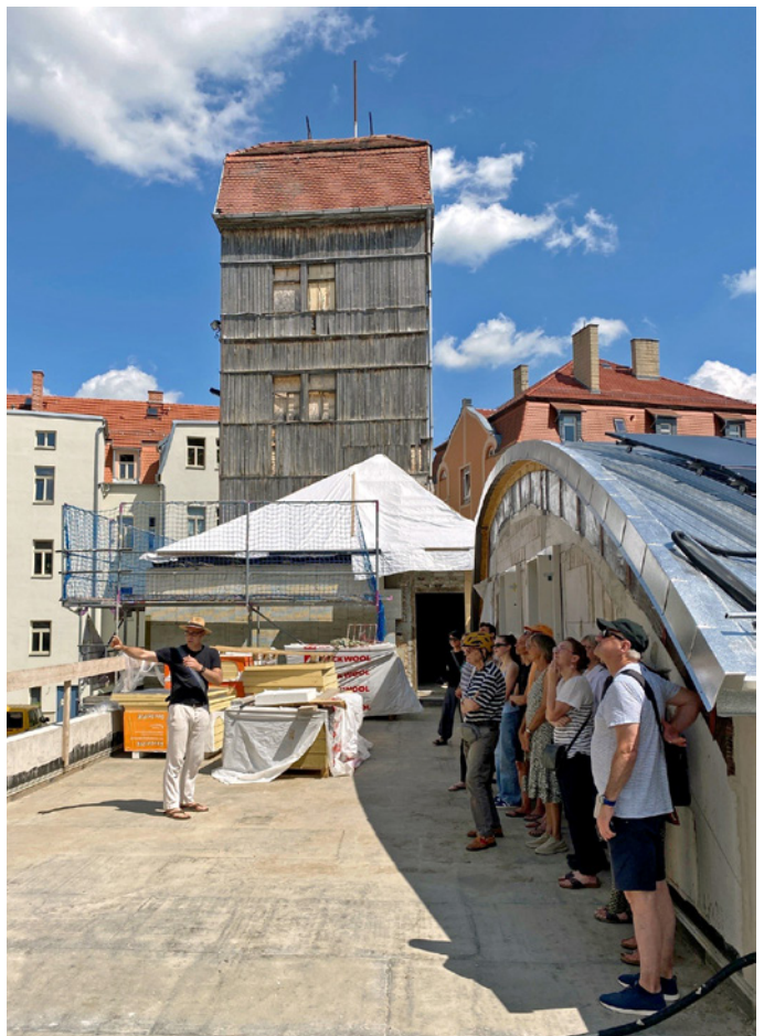
Baustellenführung durch das Quartiersprojekt Alte Feuerwache in Weimar (Architekturbüros: raum33, Wilhelm + Quednau)
